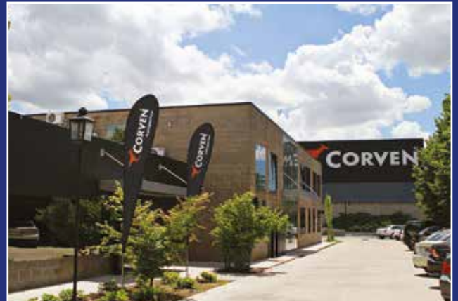
Centro de distribución - La Reja - Buenos Aires
